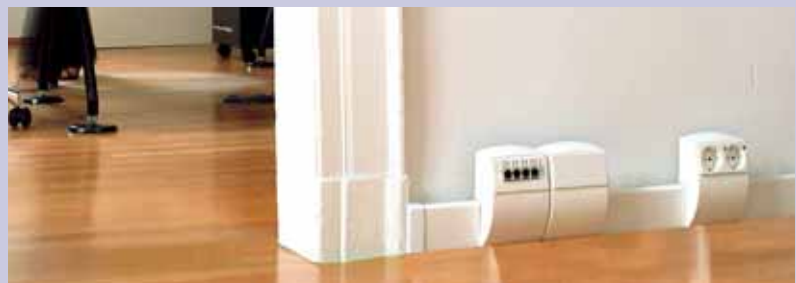
Formschöne Lösung nicht nur für Altbauten: Integration von nachgerüsteten Kabelkanälen in die Fußbodenleiste
